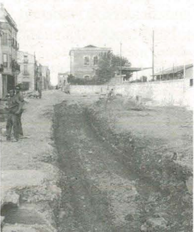
Comienzo de las obras de transformación del Paseo de la Estación. Año 1967
